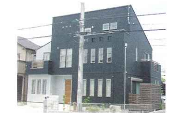
野田市S氏邸/ガルバリウムを全面に施し、ツートンカラーで仕上げたモダンな住まい。大きく片流れた屋根と規則的に並ぶ連続窓が印象的
