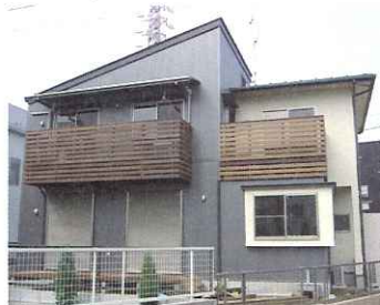
外壁の素材はモルタルとガルバリウム。屋根勾配と軒の出幅を変えている（野田市/C氏邸）
