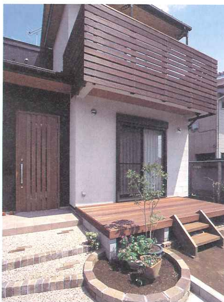
屋根の裏はさわら、ウッドデッキとバルコニーはウリン材と、雨風に触れる部分は耐水性の高い天然木を使用している
