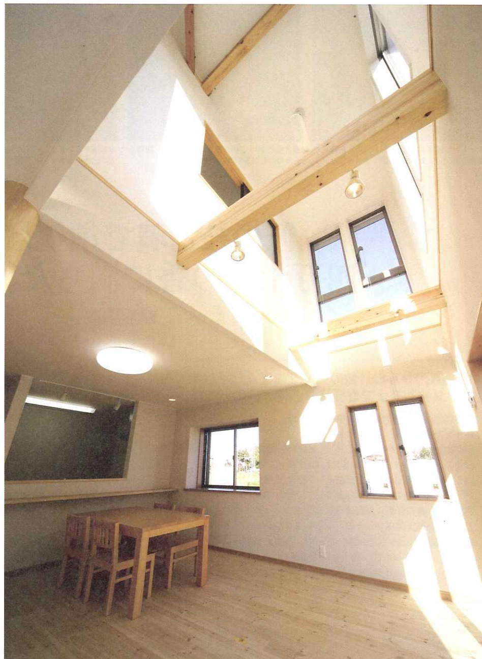
1階の親世帯のフローリングは無垢のパイン材、壁はすべて珪藻土を使用。天然素材が醸し出す優しさや心地よさが空間全体にあふれている。吹き抜けには念願の大きな窓を取り付け、光あふれる陽だまりのリビングルームが完成した
