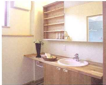
杉材を使ったオリジナルの洗面化粧台。鏡の背面がスライド収納に（施工例）
