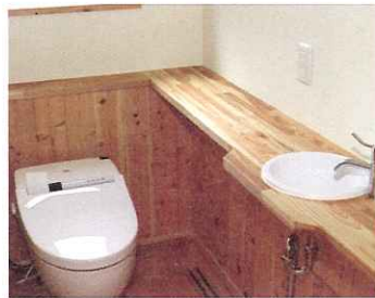
トイレには杉の腰壁に杉集成材を使ったカウンターの手洗いを設置（施工例）
