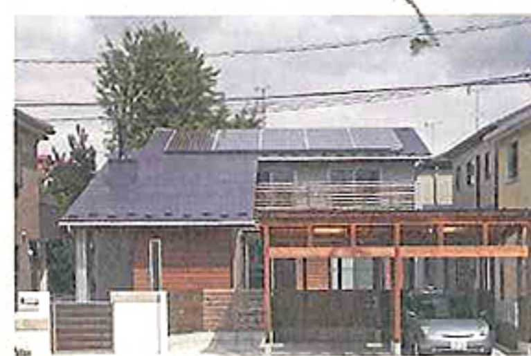
ソーラーパネルが設置された大屋根。
