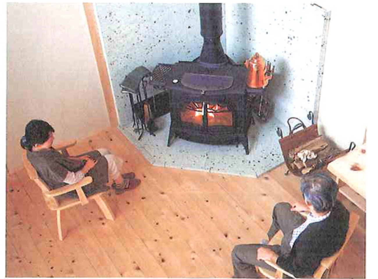
薪ストーブの前でくつろぐK夫妻。ストーブの炉台と炉壁は大谷石張り。
