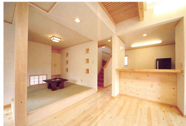
壁は珪藻土、床材は無垢の赤松、柱にはスギを使用。フローリングには天然蜜蝋ワックスを採用するなど床材はもちろん、丸柱や天井材にも天然木材がふんだんに。素足で過ごすのが一番心地いい（野田市K氏邸）
