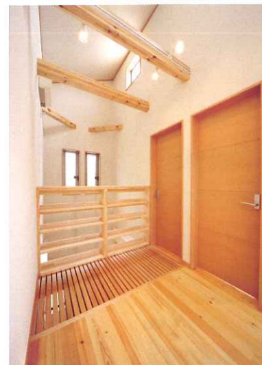
西日の光を少しでも多く1階に届けるためにスノコ状にした廊下の床（野田市K氏邸）
