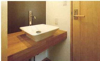
手洗いボウルはTさんが探し、それを主役に洗面化粧台を造作してもらった。カフェの洗面として利用
