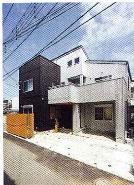
外構や玄関天井に木を、外壁にはガルバリウムを用いたクールな外観
