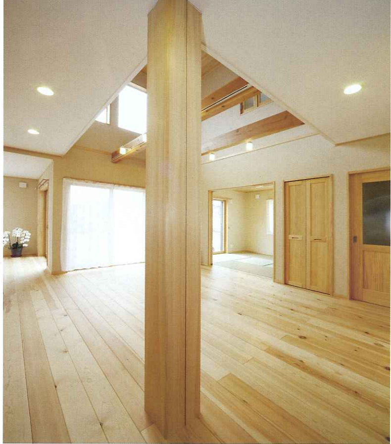
圧倒的な存在感を放つ吉野檜の大黒柱。「通し柱を入れたいとお願いしていたら、タイミングよく最上級の吉野檜が手に入ったと聞き、思い切ってリビングに入れてもらいました」と語るTさん
