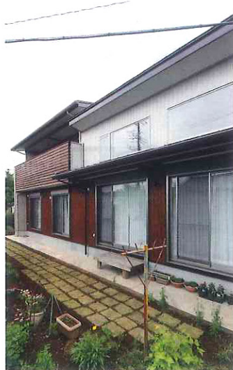
杉とガルバリウム鋼板を組み合わせた外観。右が平屋で、左が2階建ての部分である
