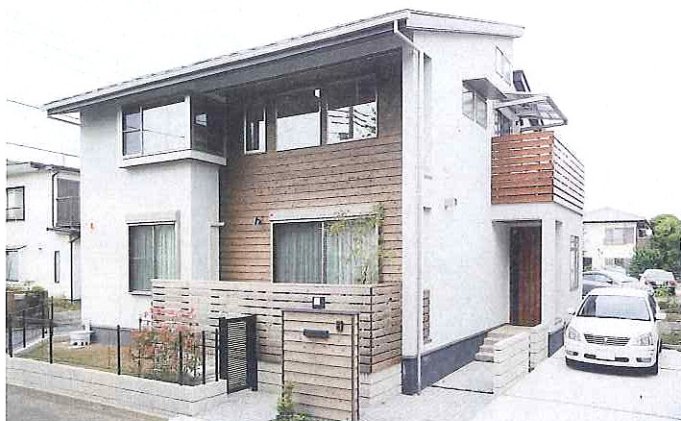
部分的に木を貼ることで温かみとモダンな雰囲気を演出している外壁。芝生が成長すれば緑も映えそう。家は公園に面して建てられており、特に2階の窓は採光と樹木の眺めに抜群の位置
