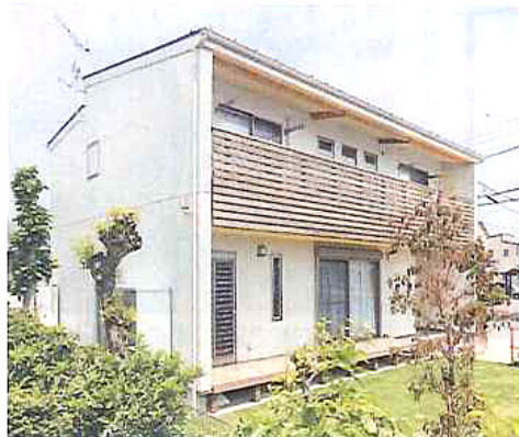
外壁に使用したガルバリウム鋼板と杉を使ったバルコニーがマッチする外観スタイル
