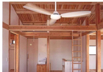
吹抜けと一体になり広々空間の2階ホールの様子です。2階は全部勾配天井になり構造が現しです。左側が寝室で右側が子供室になります。
