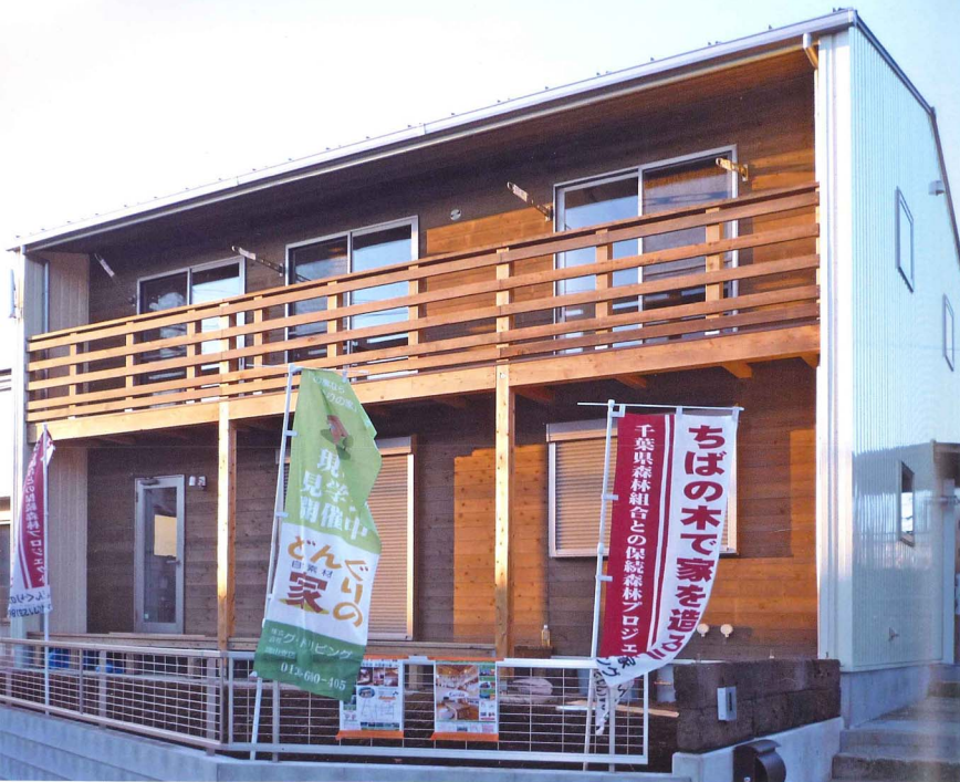
南面は一面杉板貼りそれに合わせてバルコニーとウッドデッキを一体施工、その他外壁はガルバ鋼板貼りで、構造の安定と材料の無駄を省いた1BOXタイプです。
