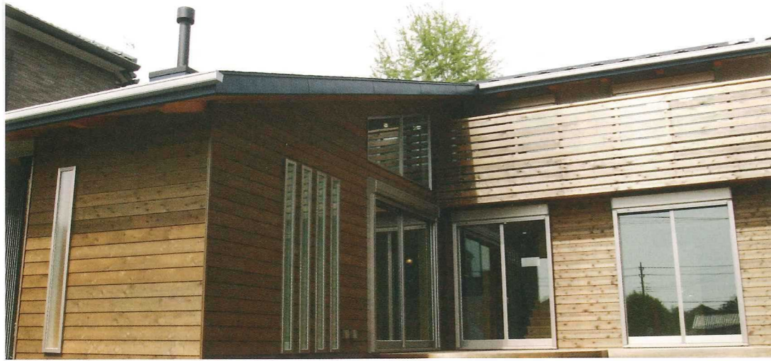
板張りの外壁は美しいだけでなく、戸外の音、熱をやわらかく遮断し、室内の心地良さを維持する。
