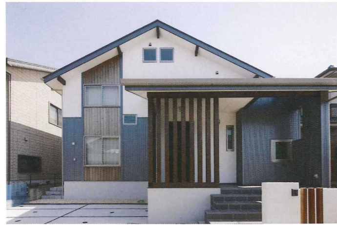
大部分を占める漆喰と無垢板の壁が真夏の外壁温の上昇を和らげてくれる。
