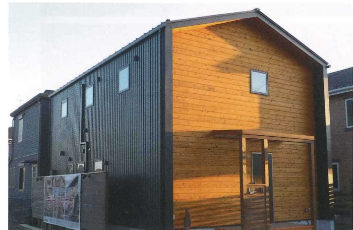
外観はアートな存在感も特長。南面はスギ無垢板張り、その他はガルバリウム鋼板張りだ。
