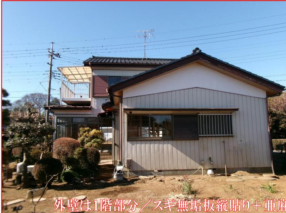
外壁は1階部分 / スギ無垢板縦貼り + 亜麻仁油主原料の保護塗料塗り、2階部分 / 漆喰系塗壁仕上げ
